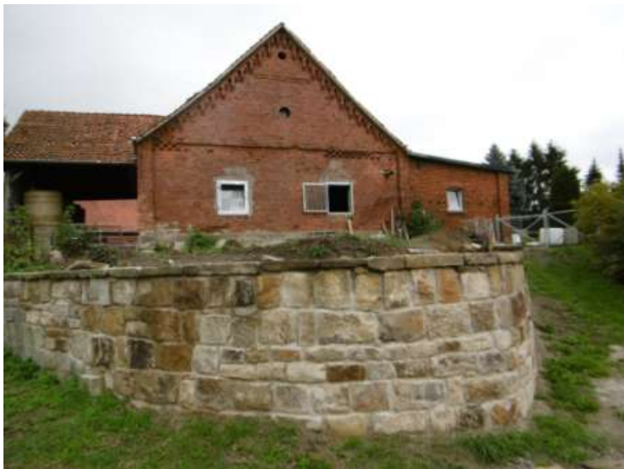
Abbildung 9: Natursteinmauer in Pötzen
