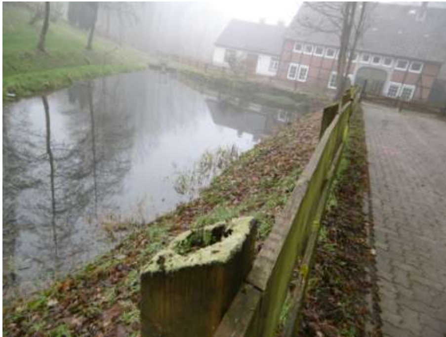
Abbildung 50: historischer Teich der „Höllmühle“ in Langenfeld
