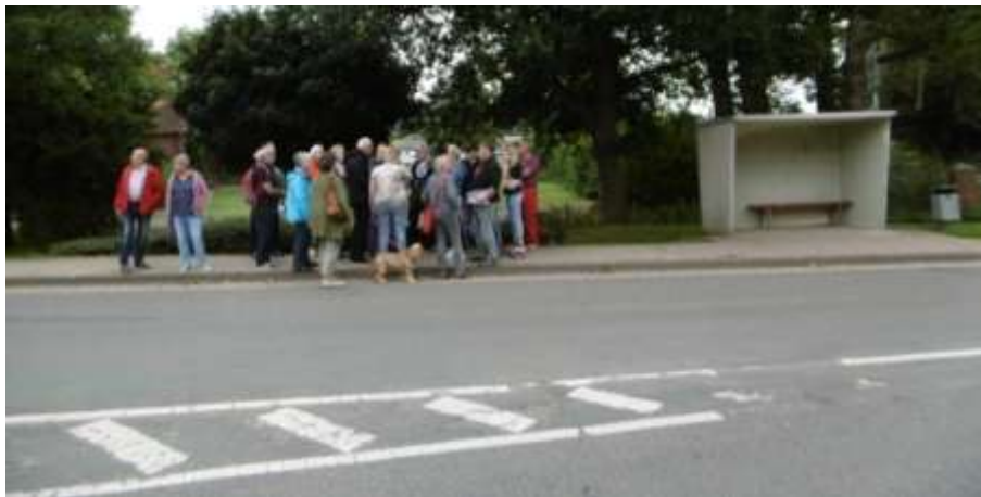
Abbildung 33: Risikobereich Bushaltestelle an der K 88 in Höfingen
