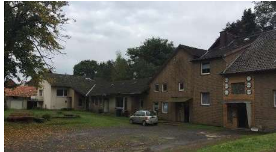
Abbildung 17: Der Mühlenhof in Pötzen vor Beginn der Erneuerung
