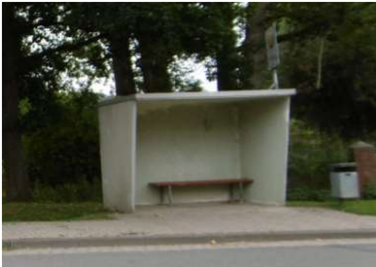
Foto: Betonbuswartehäuschen in Höfingen
