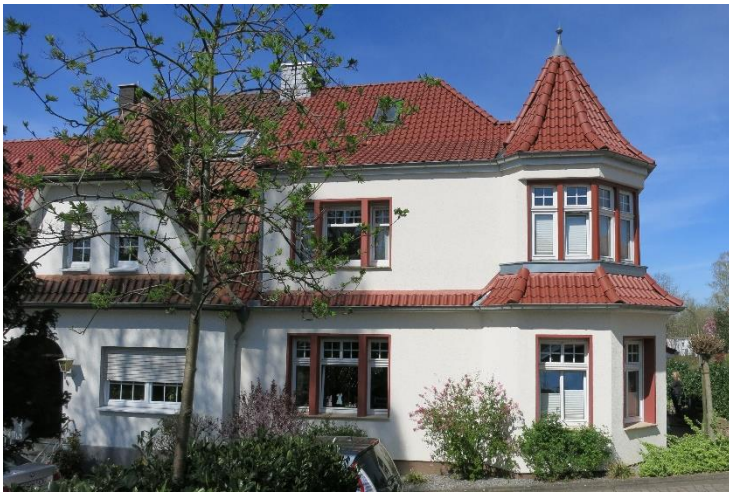
Turm am Gebäude Karolinenhöhe 2 Fotos: PLANUNGSBÜRO FLASPÖHLER
