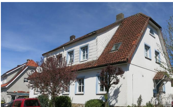
Satteldach mit Krüppelwalm und Schleppgaube
