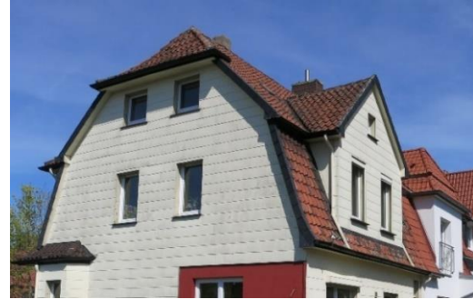
Mansardendach mit Krüppelwalm und Dachaufbau mit Giebelgaube
