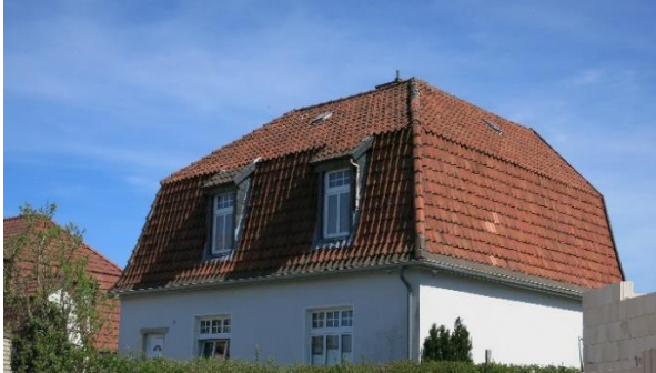
Mansardenwalmdach mit zwei für diese Dachform typischen Schleppgauben
