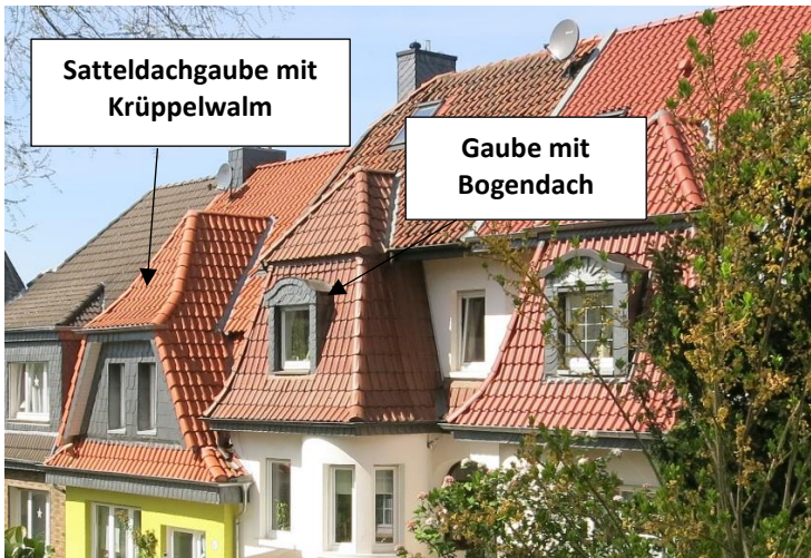
Verschiedene Dachgauben und Dachaufbauten
