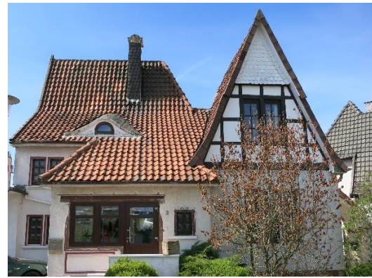
Zusammengesetztes Dach und Fledermausgaube
