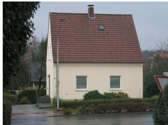
Typisches Siedlungshaus der 1950er-Jahre aus Schüttbeton
